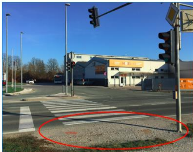
Slika 22: Potrebna ureditev od vozišča nivojsko ločenega čakališča za pešce
